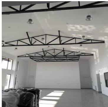
Fig.1 Exemple de utilizare a grinzilor cu zăbrele
